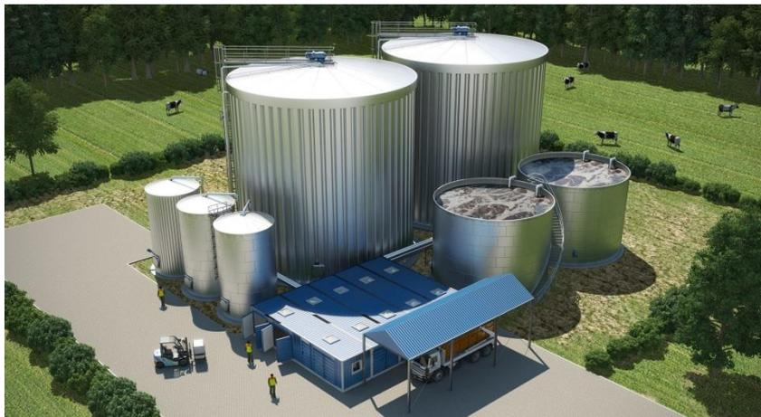
Photo : Une laiterie industrielle produit du biogaz grâce à une installation de traitement biologique multiniveaux permettant de valoriser les eaux résiduaires fortement polluées et les déchets liquides.
