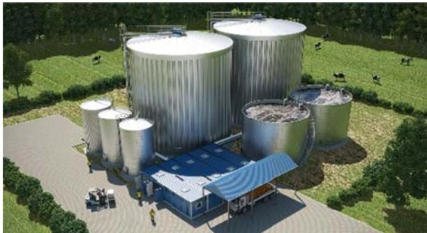
Mit einer mehrstufigen biologischen Behandlungsanlage für hochbelastete Abwasserströme und flüssige Abfälle erzeugt eine Großmolkerei Biogas.
