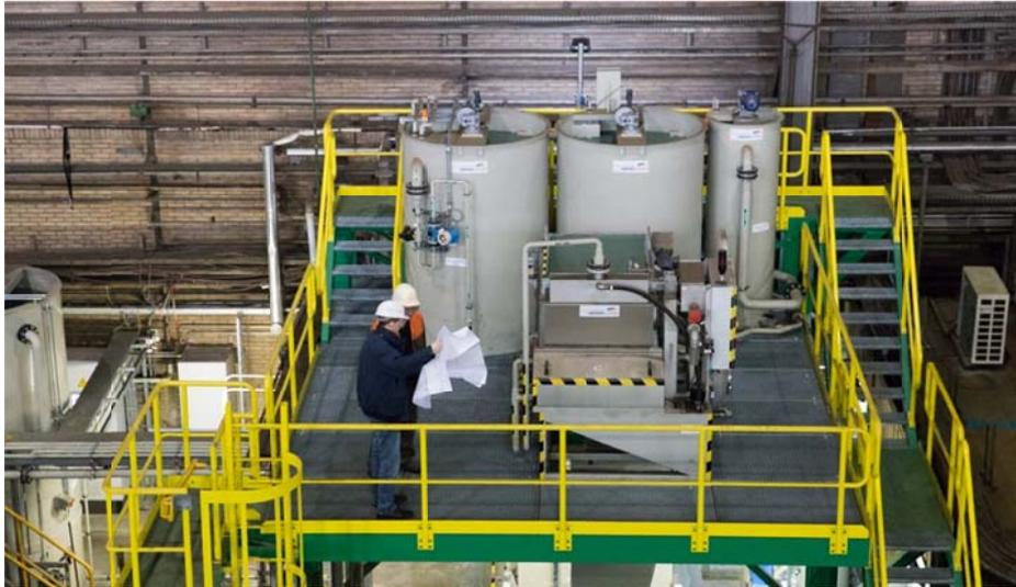
Chemisch-physikalische Abwasserbehandlungsanlage zur sicheren Entfernung von Chrom(III) und Ameisensäure aus dem Abwasser.
