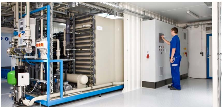
Bild: Lugan Flotationsanlage in einer modular aufgebauten EnviModul-Anlage zur Nachbehandlung von Molkereiabwässern
