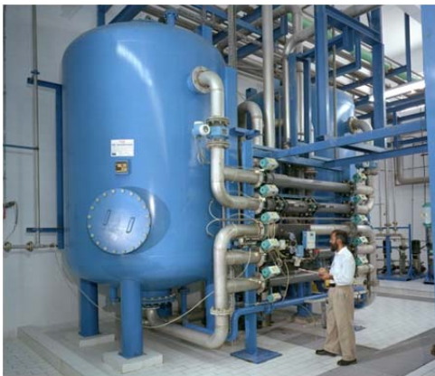
Bild: Teilansicht der Anlage: Mehrschichtfilter zur Brunnenwasserfiltration vor der Umkehrosmose.
