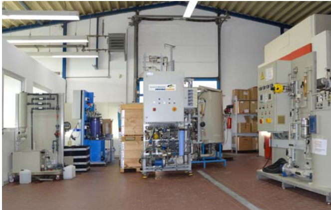
Bild: EnviroChemie hat die Kapazitäten für Technikums- und Laborversuche erweitert.
