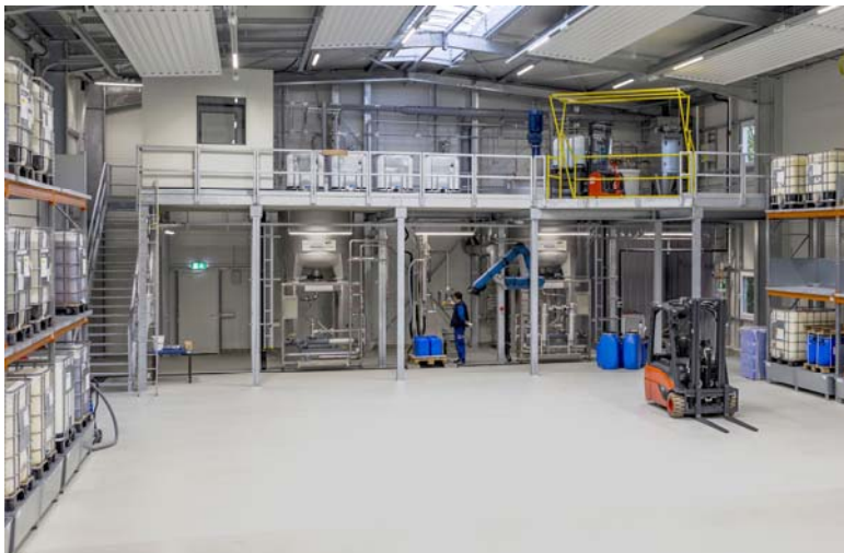
Bild: EnviroChemie hat am Hauptstandort Anfang 2016 die neue Anlage zur Herstellung von Produkten für die Wasserbehandlung in Betrieb genommen.
