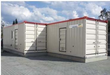
*Die EnviModul Lugan-Anlage besteht aus zwei Modulen und ersetzt ein eigenes Technikgebäude*
