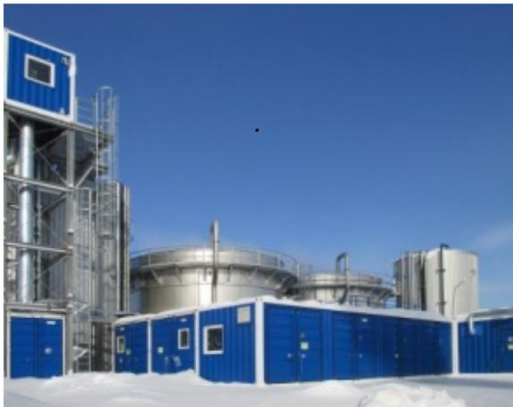
Bild: Modular zusammengestellte Abwasserbehandlungsanlage für eine Molkerei in Russland
