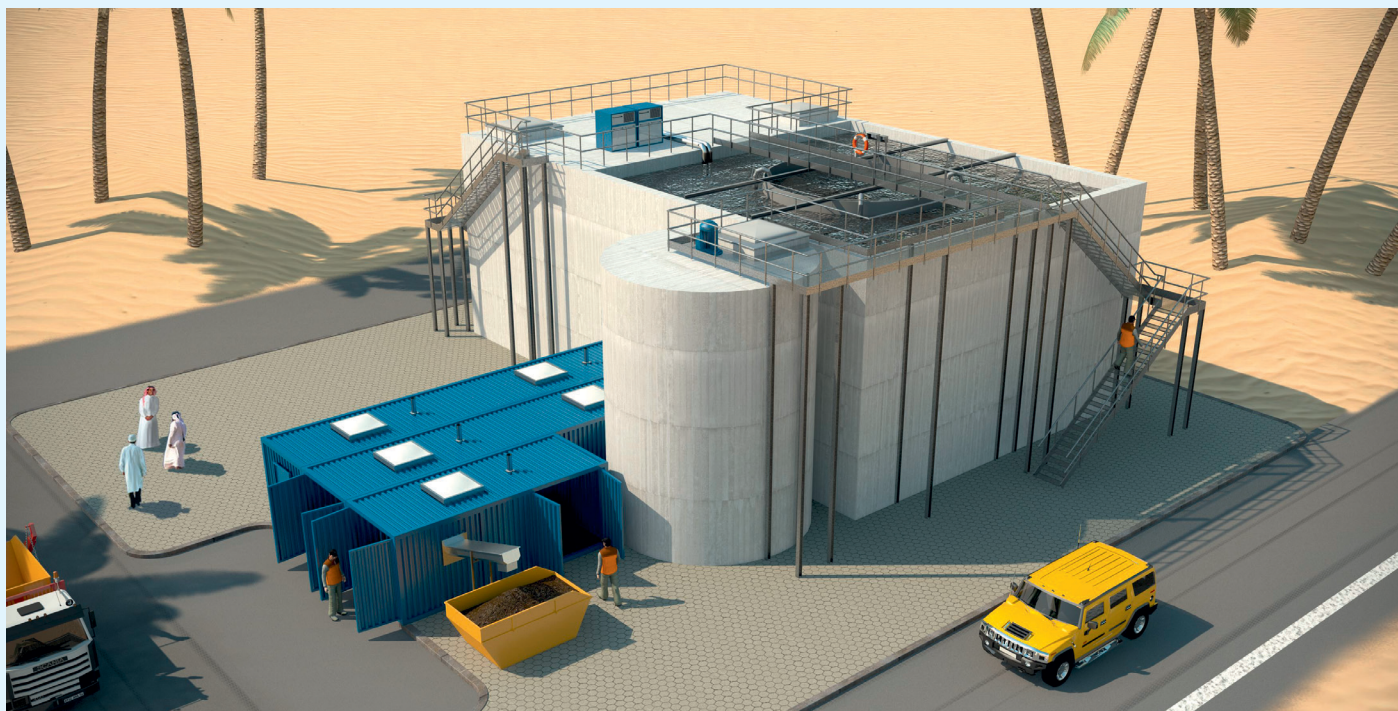
Bild 1 Zero Liquid Discharge ist vor allem in Regionen, in denen das Wasser knapp ist, eine Alternative. Im Vordergrund steht hier die Wiederverwertung, beispielsweise zur Kühlung, Reinigung, Bewässerung oder für Sanitäranlagen.
