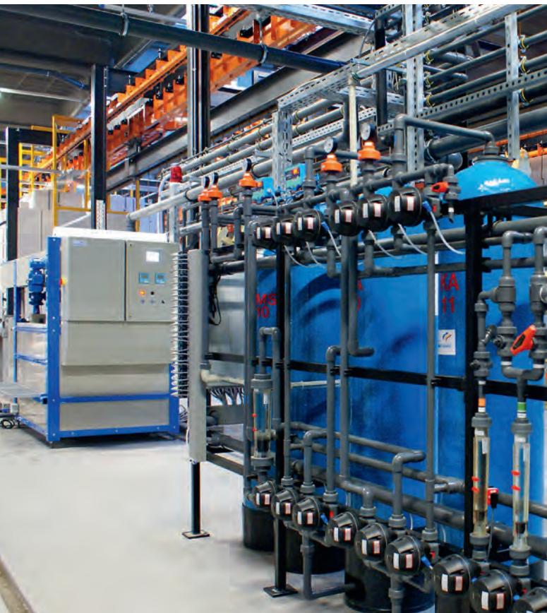
Une installation décentralisée à traitement intégré pour épuration et recyclage des eaux usées dans l'industrie automobile.
