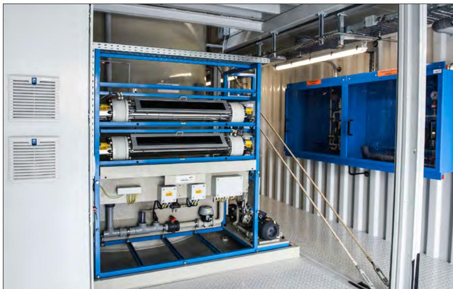
Die verschiedenen Anlagekomponenten sind kompakt im Modul angeordnet.
