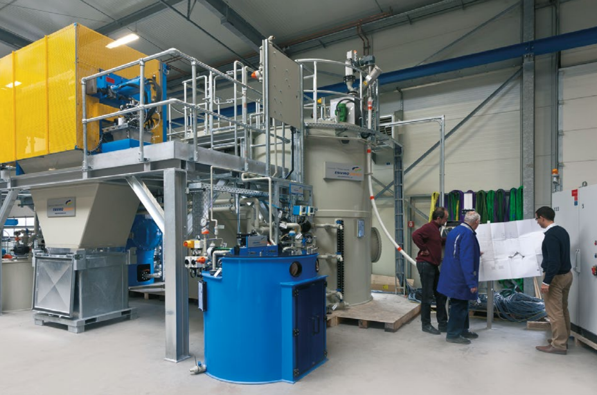
Enviochem®-Anlage zur chemisch-physikalischen Abwasseraufbereitung bereit für die Abnahmeprüfung
