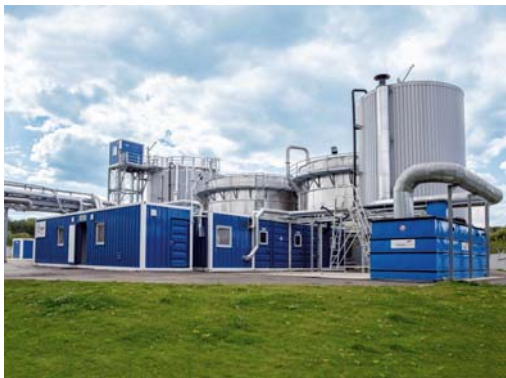
Bild: In einer mehrstufigen, biologischen Anlage in modularer Ausführung werden Molkereiabwässer behandelt.
