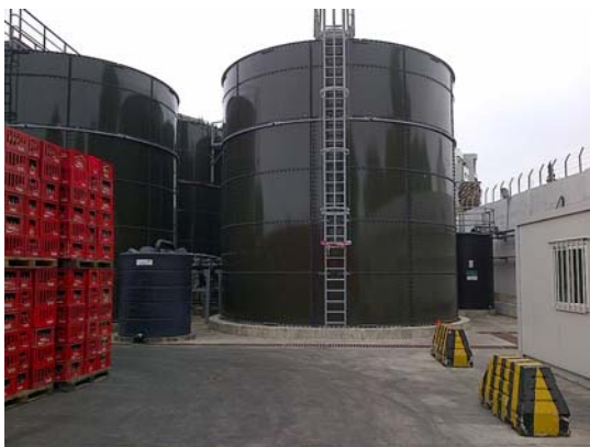
Bild: Kompakte mehrstufige biologische Biomar Abwasserbehandlungsanlage mit Biogaserzeugung für ABC Atlas Bottling in Marokko.
