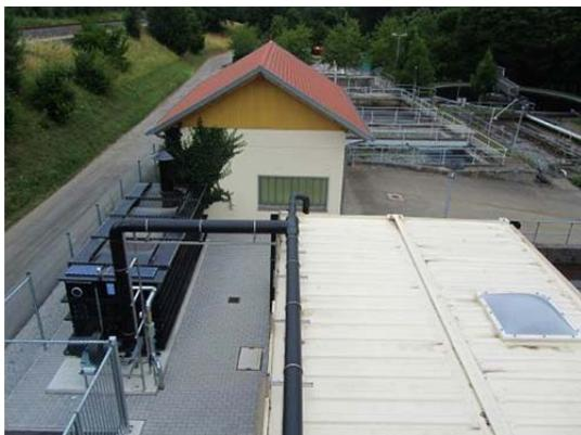
Blick von oben auf die von EnviroChemie installierte Anlagentechnik: Vorn rechts die Abwasservorbehandlungsanlage im EnviModul (weiß), links davon die Biomar Abluftreinigungseinheit (schwarz), im Hintergrund die biologische Reinigungsstufe der Kläranlage.
