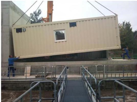
Die fix und fertig vormontierte modulare EnviModul Flomar® Abwasservorbehandlungsstufe für die Molkereiabwässer wird geliefert.
