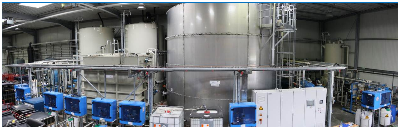
Gesamtansicht der von EnviroChemie installierten Abwasserreinigungs- und Wasserrecyclinganlage
