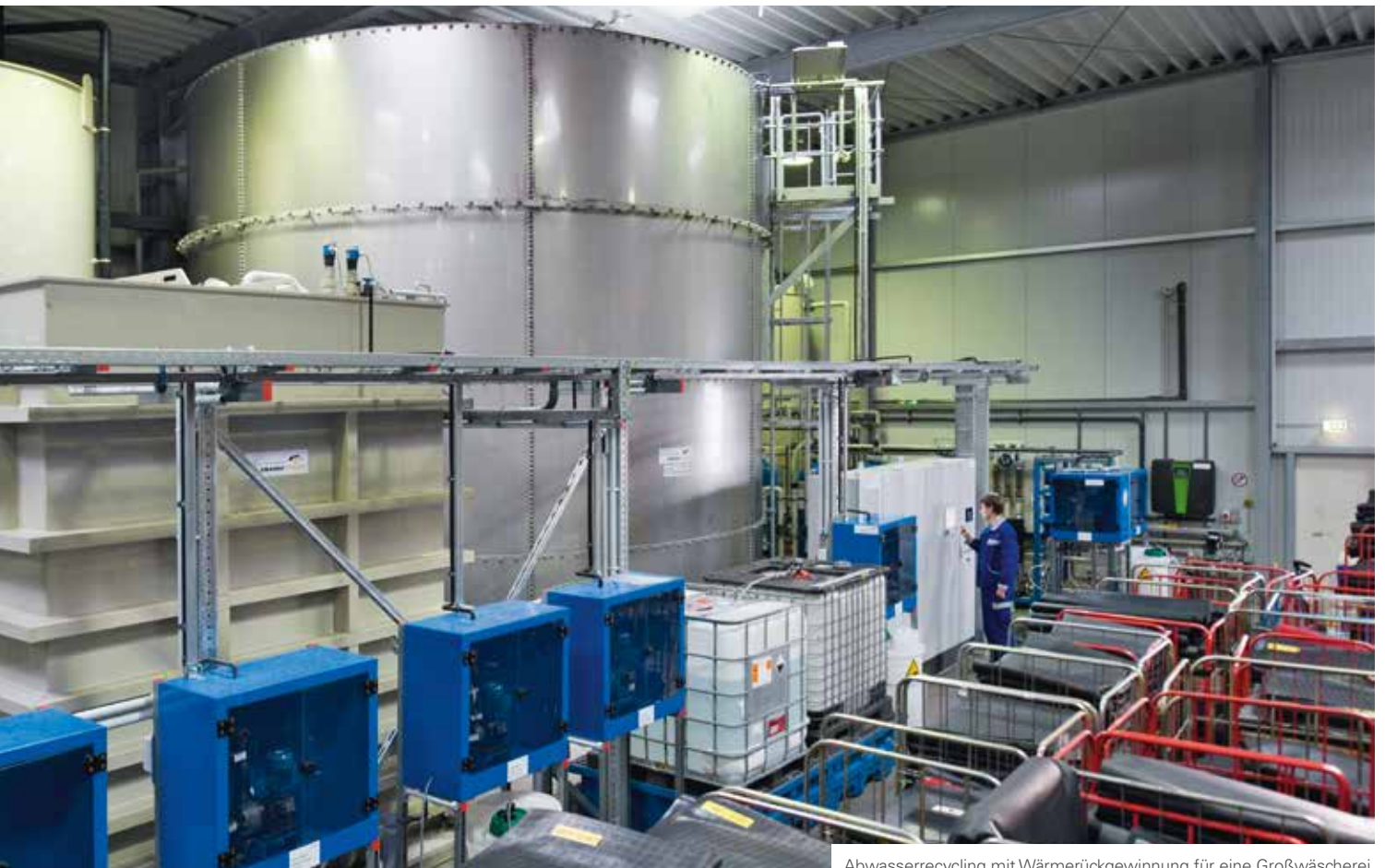
Abwasserrecycling mit Wärmerückgewinnung für eine Großwäscherei.
